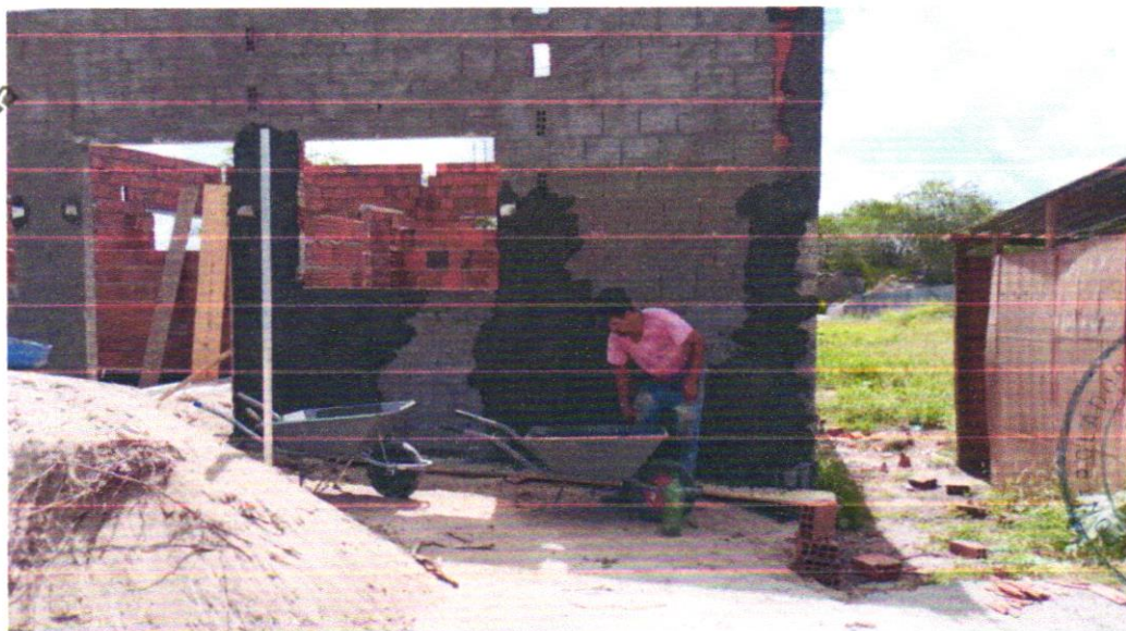
FOTO 05 – CHAPISCO APLICADO EM ALVENARIAS E ESTRUTURAS DE CONCRETO INTERNAS, COM COLHER DE PEDREIRO. ARGAMASSA TRAÇO 1:3 COM PREPARO EM BETONEIRA 400L. AF_06/2014
