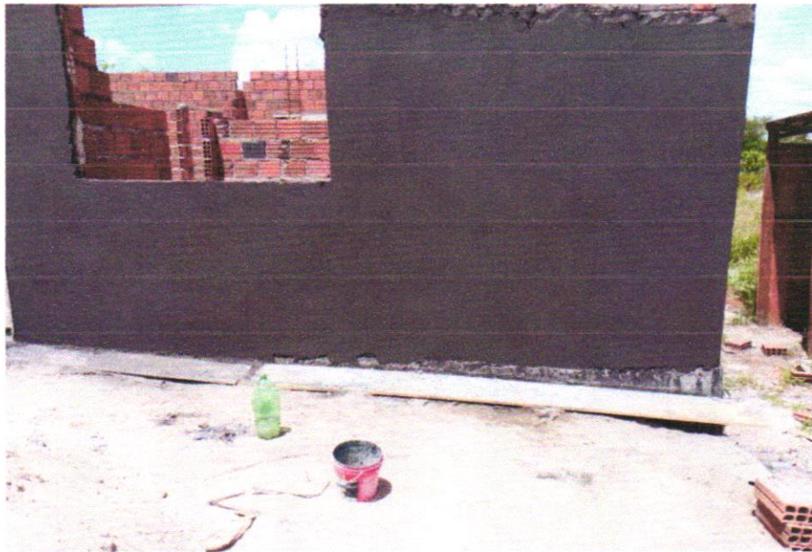
Foto 09– MASSA ÚNICA, PARA RECEBIMENTO DE PINTURA, EM ARGAMASSA TRAÇO 1:2:8, PREPARO MANUAL, APLICADA MANUALMENTE EM FACES INTERNAS DE PAREDES, ESPESSURA DE 10MM, COM EXECUÇÃO DE TALISCAS. AF_06/2014
